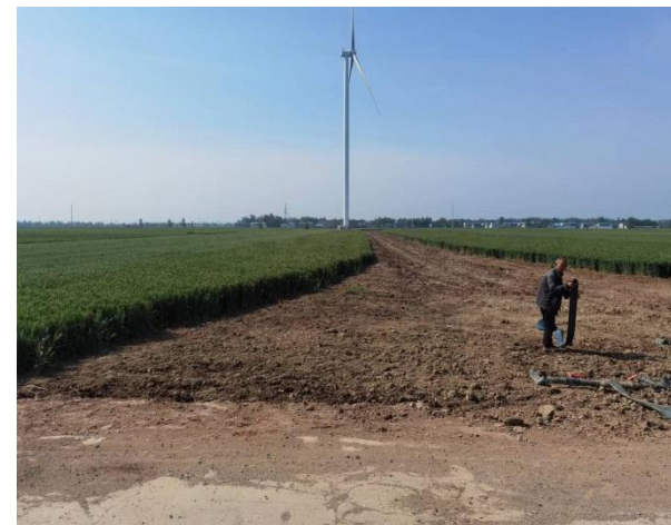
临时占地场地平整情况②
