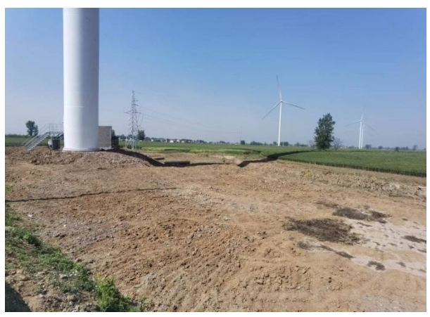
临时占地场地平整情况①
