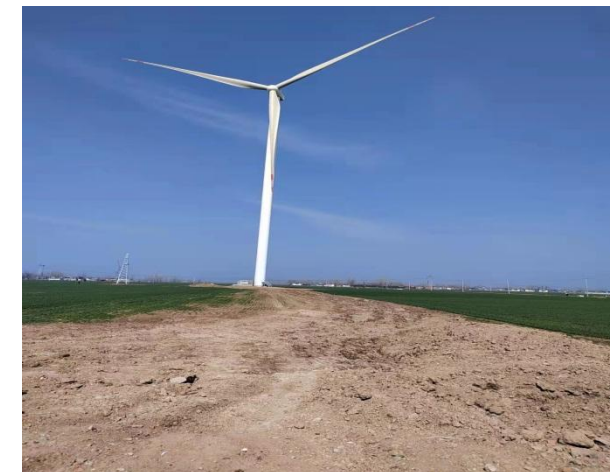
临时占地场地平整情况③
