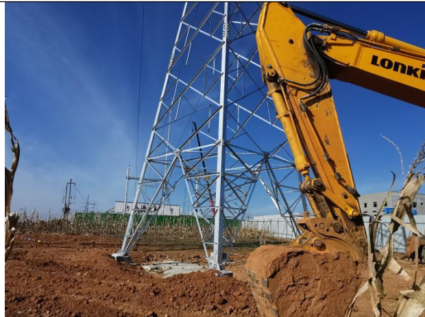
N01 杆塔土地整治中
