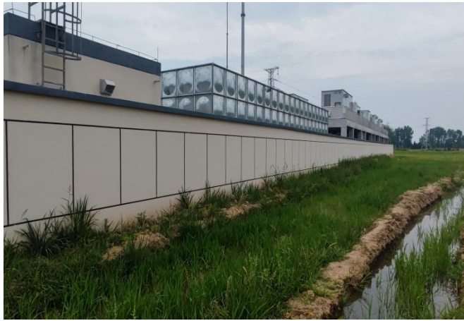
升压站四周厂界复耕
