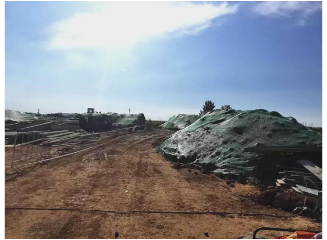
临时土方覆盖
