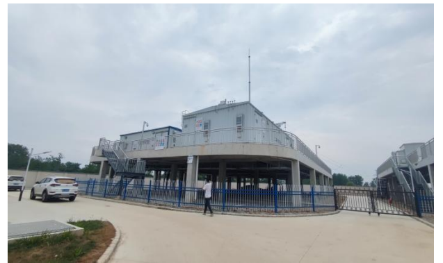
升压站内硬化
