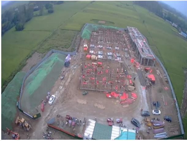
施工围挡及覆盖
