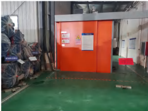
防护门及电离辐射标志
