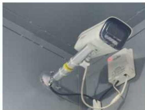
固定式辐射仪监测探头
