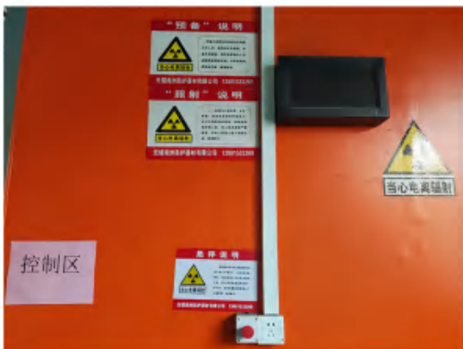
声光报警装置和急停按钮
