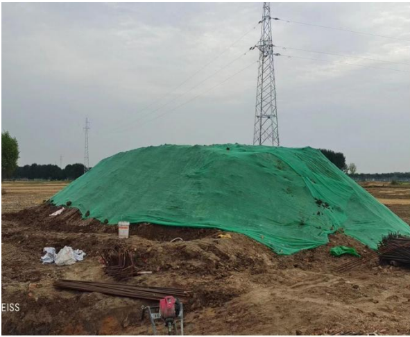
F02 风机施工场地堆土临时覆盖
