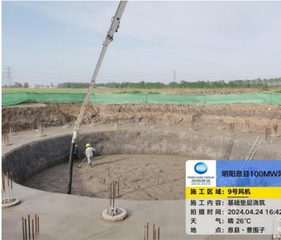
F10 风机施工场地四周设置围挡
