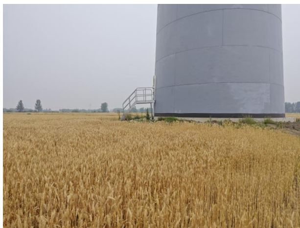
F01 风机施工场地整治后恢复为水浇地
