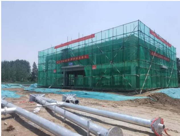
升压站施工期设置围挡、堆土临时覆盖
