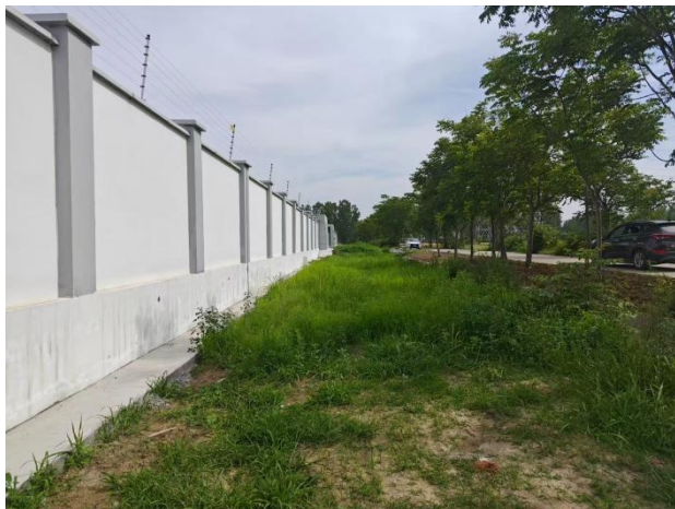
升压站围墙外种草绿化
