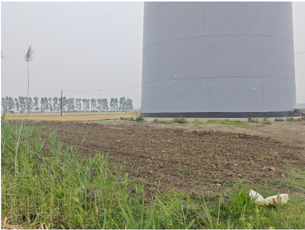
F10 风机施工临时占地恢复为草地和农田
