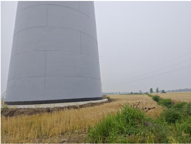
F02 风机施工临时占地恢复为水浇地
