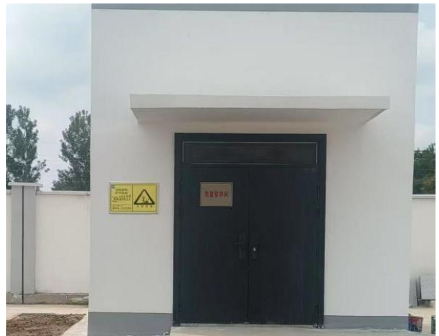
升压站危废贮存间
