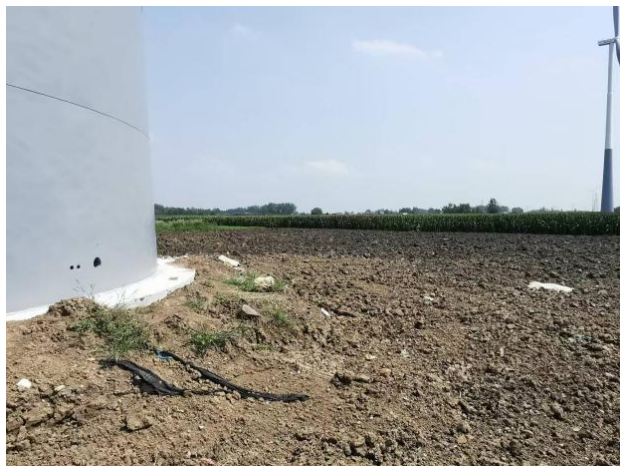
F01 风机施工场地整治中
