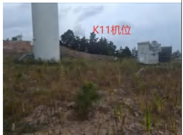
K11 风机吊装平台生态恢复
