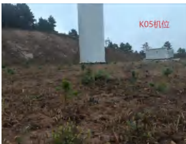
K05 风机吊装平台生态恢复
