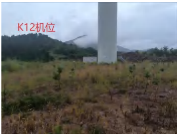
K12 风机吊装平台生态恢复
