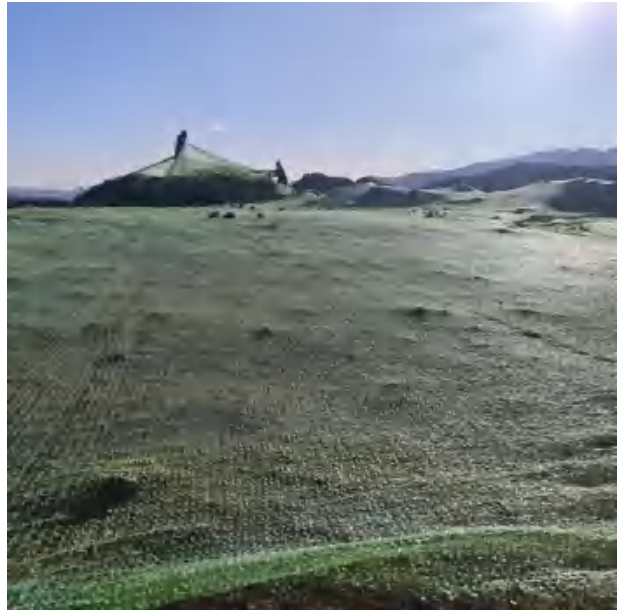
施工现场裸露地表覆盖
