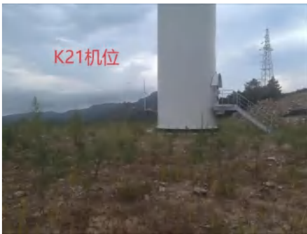
K21 风机吊装平台生态恢复
