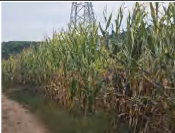
集电线路地埋电缆区生态恢复
