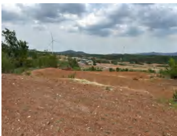
K14 风机临时施工道路已进行表土回覆并种植农作物
