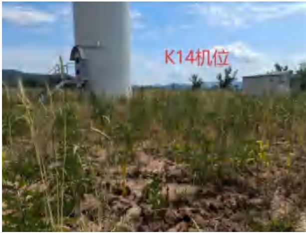
K14 风机吊装平台生态恢复
