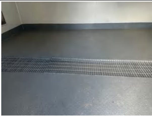
危废贮存间地面防渗及收集沟
