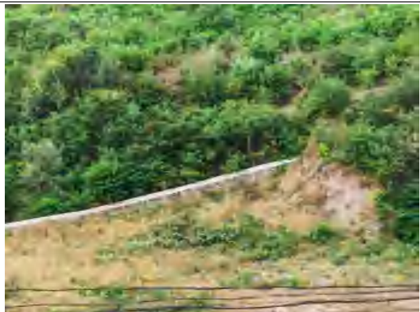
弃土场挡土墙
