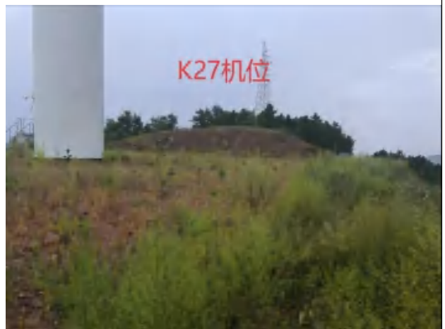
K27 风机吊装平台生态恢复
