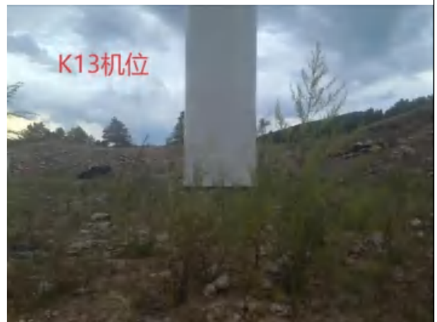
K13 风机吊装平台生态恢复
