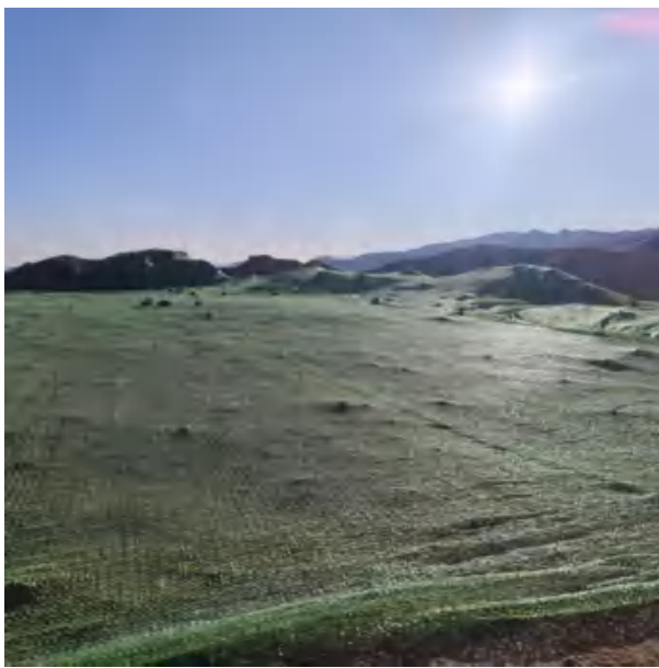
施工现场裸露地表覆盖
