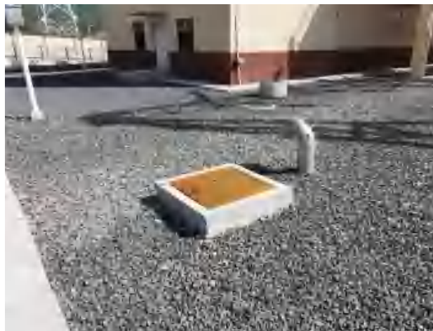
主变事故油池
