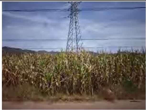
集电线路地埋电缆区生态恢复
